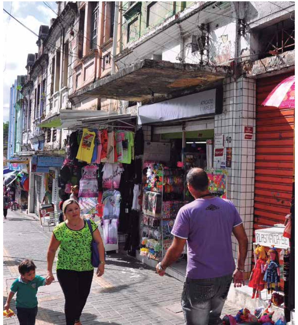
As marquises com problemas podem desabar e atingir quem estiver passando embaixo
